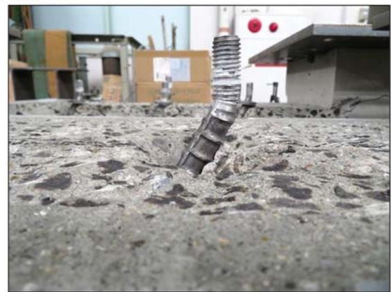
(d) アンカー筋のダボ変形
